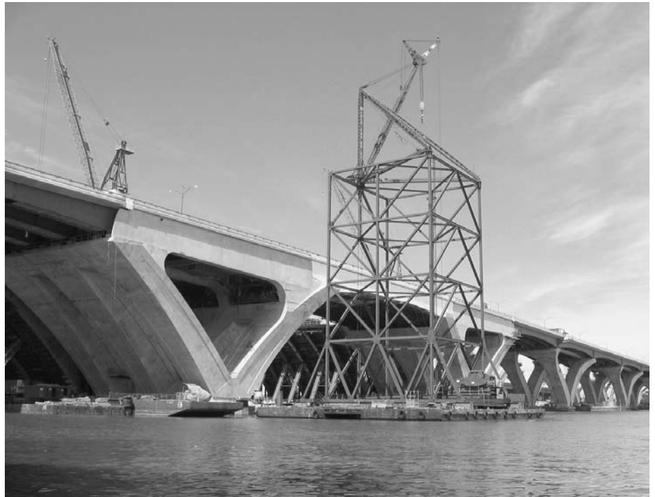
Tramo nuevo del puente Woodrow Wilson que se abrió al tráfico en Washington, D.C. el año pasado, luego de arduas labores de reconstrucción. Se han sometido varios proyectos de ley a consideración del Congreso para reconstruir la infraestructura decrepita de EU, pero lo que se necesita es un enfoque al más alto nivel para aportar el financiamiento y la voluntad política necesarios para hacerlos realidad. (Foto: Aude Vivere/Creative Commons).
