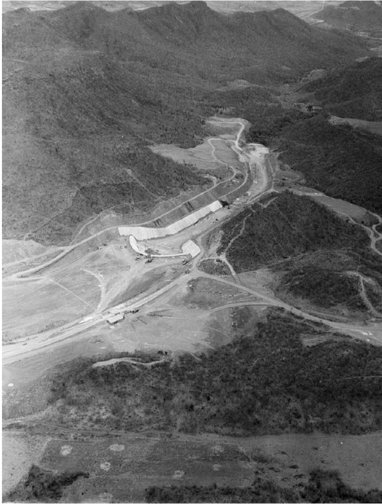
La presa López Mateos sobre el río Humaya en Sinaloa, en 1963. La construcción de estas obras de infraestructura para el bienestar general se postergó indefinidamente después de 1982, cuando la City de Londres y Wall Street aplastaron los planes de desarrollo del presidente López Portillo y le entregaron México a los librecambistas. (Foto: ONU).
